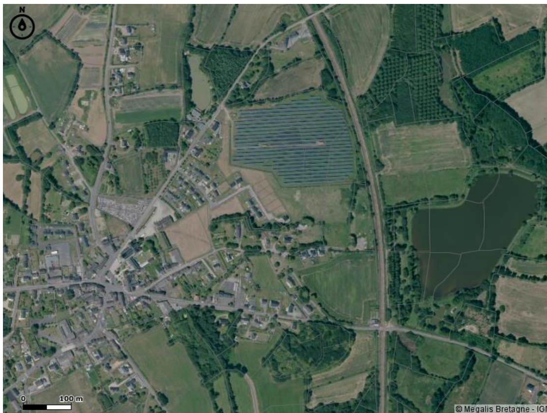
Figure 162 : Photo aérienne du parc photovoltaïque de Bonnemain (Service géomatique - Bretagne romantique 2019)
