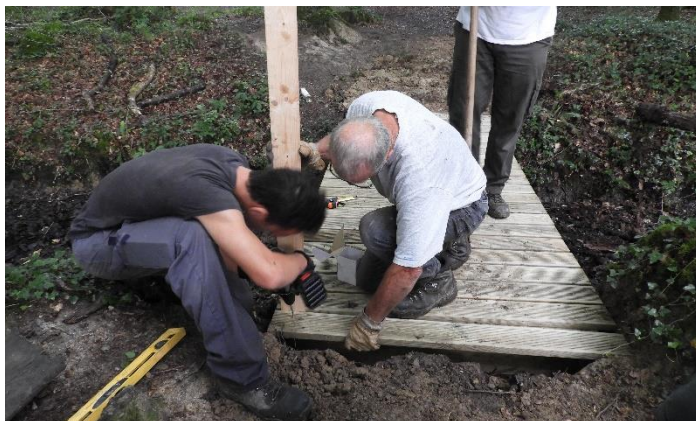
Figure 56 : Travaux d'entretien en forêt du Mesnil (Service Environnement Bretagne romantique 2018)
