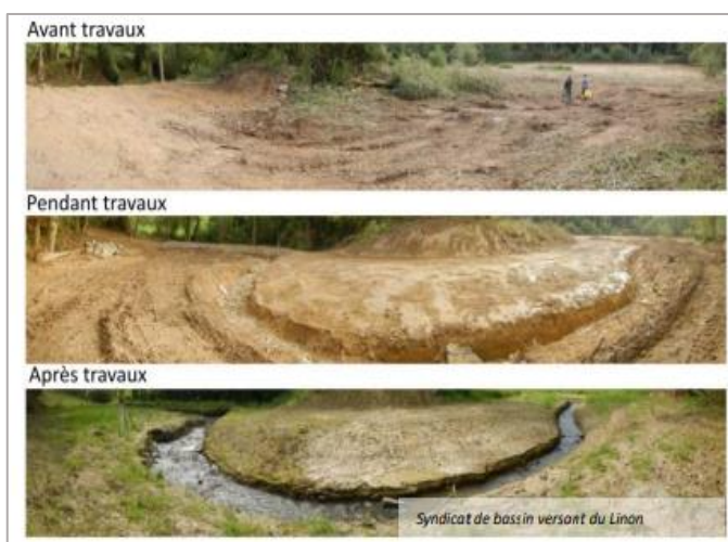
Figure 175 : Bras de contournement réalisé en 2017 sur l’étang du Moulin - SAGE RFBB
