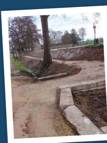
Longaulnay Aménagement piétonnier
