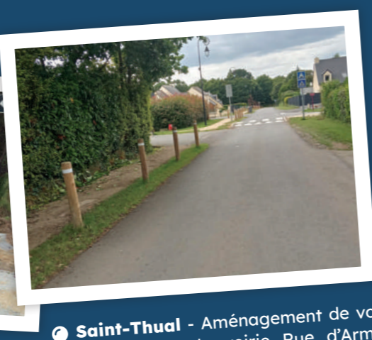
Tinténiac - Aménagement d'aires et quai de bus
